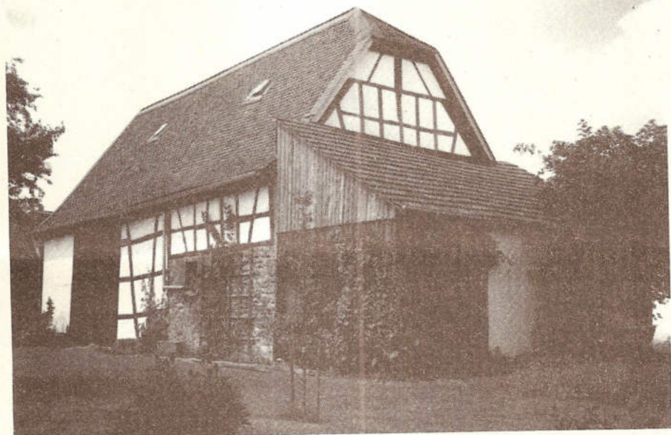
Auch die Scheune des Erbacher Hofes zeigt sich wieder im Glanz
