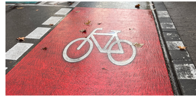
Erweiterung und Mittelerhöhung Umbau Knotenpunkte Klarenthaler Straße
